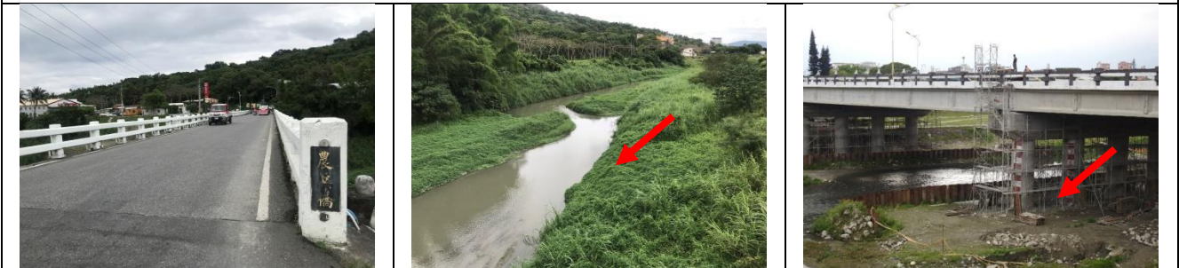
圖 12-14. 美崙溪下游~農兵橋、尚志橋等流域，河道稍寬、水量稍多、流速緩慢。尚志橋目前施工單位正在進行橋樑維修作業，不便進行調查。
