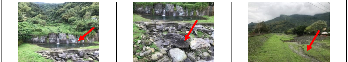
圖 36-37. 從翠堤橋上往吉安溪山谷眺望，大型攔砂壩可防止山崩落石、土石流瞬間沖入吉安溪。
