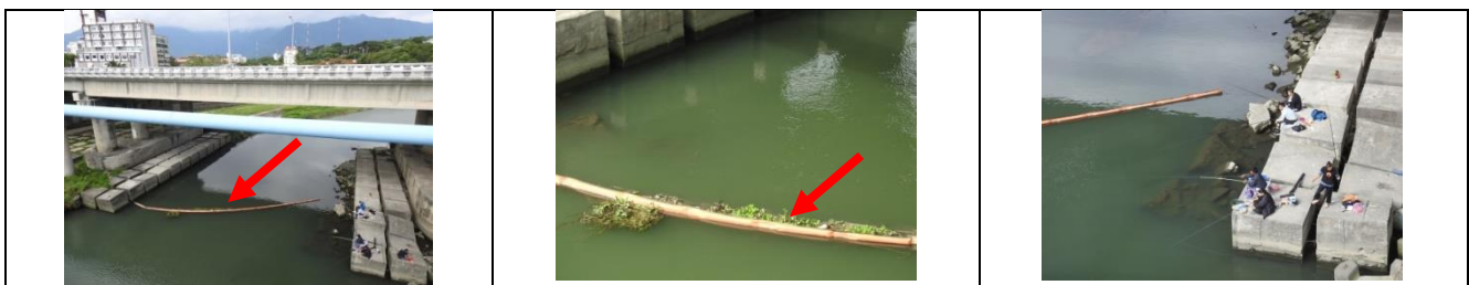
圖 24-26 109.12.08.第一次考察 ，我們發現鄰近曙光橋的中山橋下，設置了橘色厚帆布製成的垃圾攔截繩，可以攔截到少許的布袋蓮、汙泥，河岸邊還有民眾在垂釣呢!
