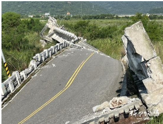
照片 5：高寮大橋 (公視還資中心)
