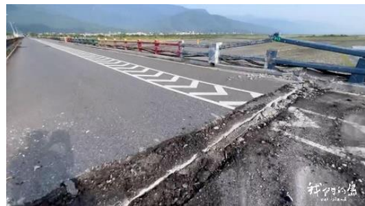
照片 8：高寮大橋 (公視還資中心)
